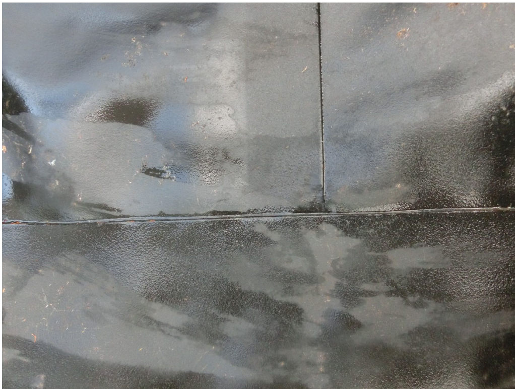
Abb. 4: Detailaufnahme T-Naht des Prüfkörpers am Testende
