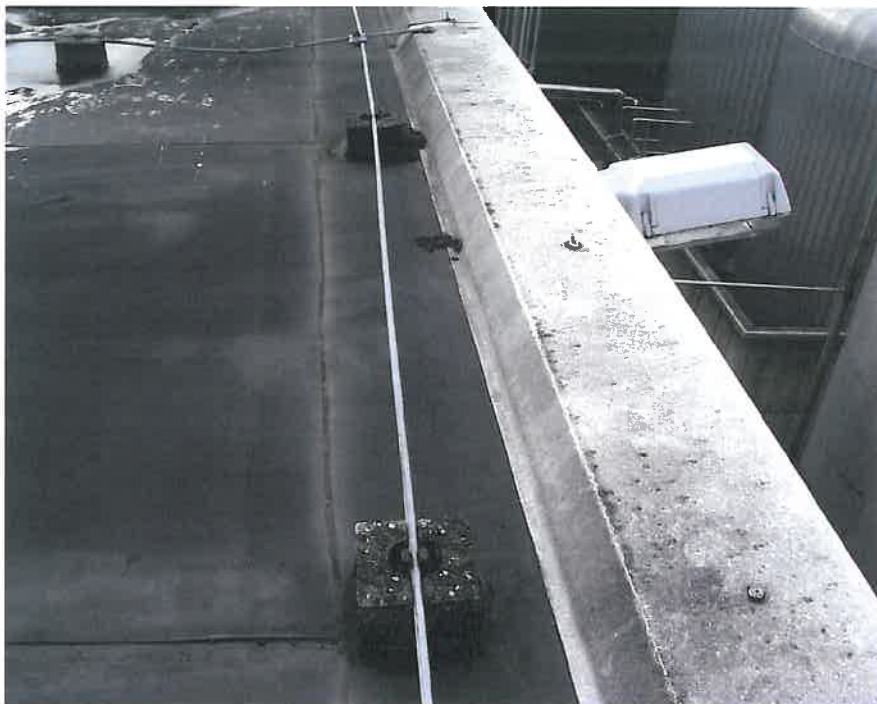
Bild 2: Übersichtsaufnahme der Attika des Objektes Karlsberg Brauerei Homburg nach 28 Jahren Liegezeit; nur sehr geringe Schrumpfspannungen erkennbar
