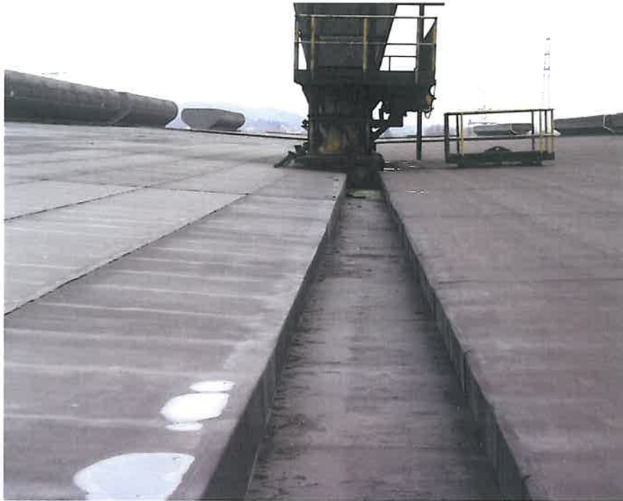
Bild 1: Übersichtsaufnahme der Rinne des Objektes Dillinger Hütte nach 29 Jahren Liegezeit; keine Schrumpfspannungen erkennbar
