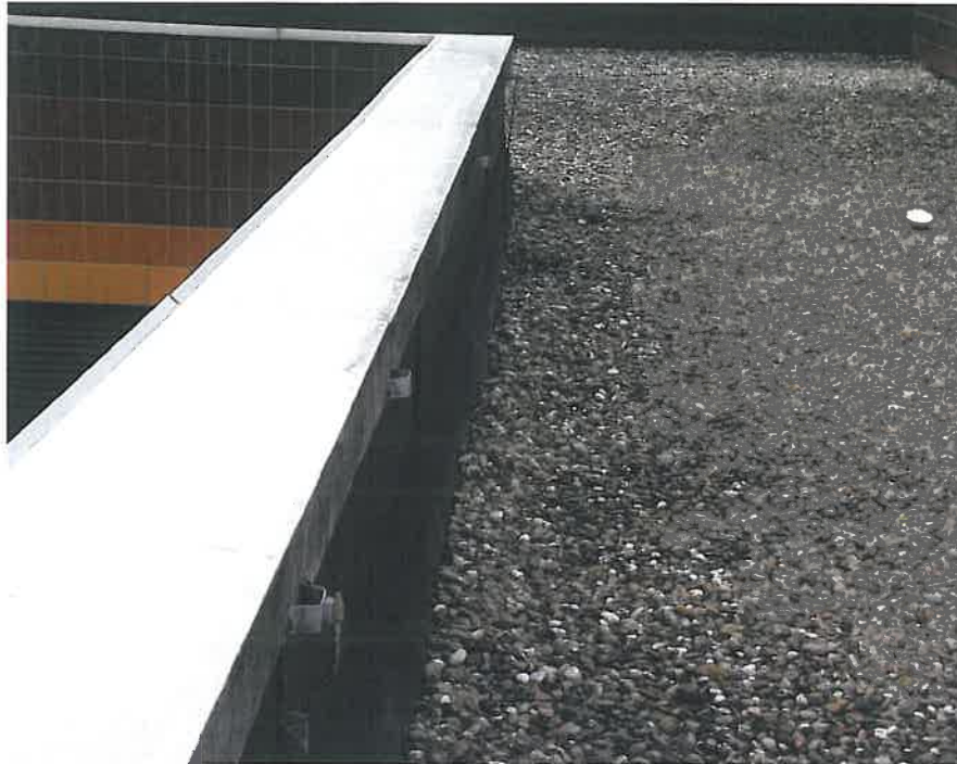
Bild 5: Übersichtsaufnahme der Attika des Objektes Berufsbildungszentrum Wadern nach 30 Jahren Liegezeit; keine Schrumpfspannungen erkennbar
