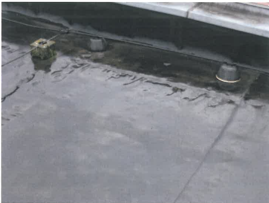
Bild 6: Übersichtsaufnahme der Attika des Objektes SaarGummi-Halle 22 nach 36 Jahren Liegezeit; keine Schrumpfspannungen erkennbar
