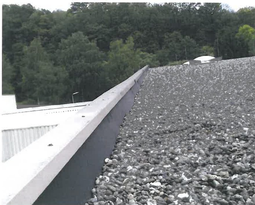
Bild 4: Übersichtsaufnahme der Attika des Objektes Bundeswehrbekleidungsamt Primstal nach 27 Jahren Liegezeit; keine Schrumpfspannungen erkennbar
