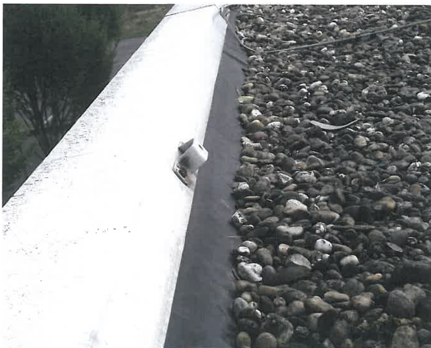
Bild 3: Übersichtsaufnahme der Attika des Objektes Hallenschwimmbad Wadern nach 30 Jahren Liegezeit; keine Schrumpfspannungen erkennbar
