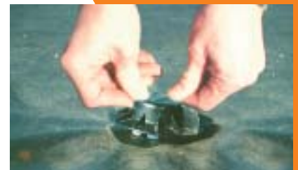
Aufdrücken der COiT- Klemmhalter-Oberteile
