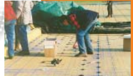
Befestigung der Klemmhalter- unterteller mit geeigneten Schrauben und Schraubern
